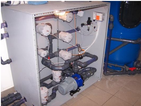
fachgerechte Montage vor Ort
